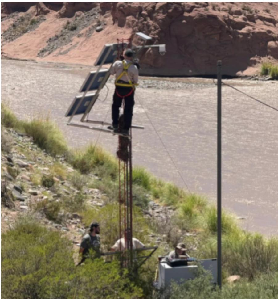
El Departamento General de Irrigación concretó una importante actualización tecnológica en la estación hidrometeorológica La Jaula, ubicada en la cuenca alta del río Diamante, con el objetivo de mejorar el monitoreo y la transmisión de información clave sobre las condiciones de alta montaña.
